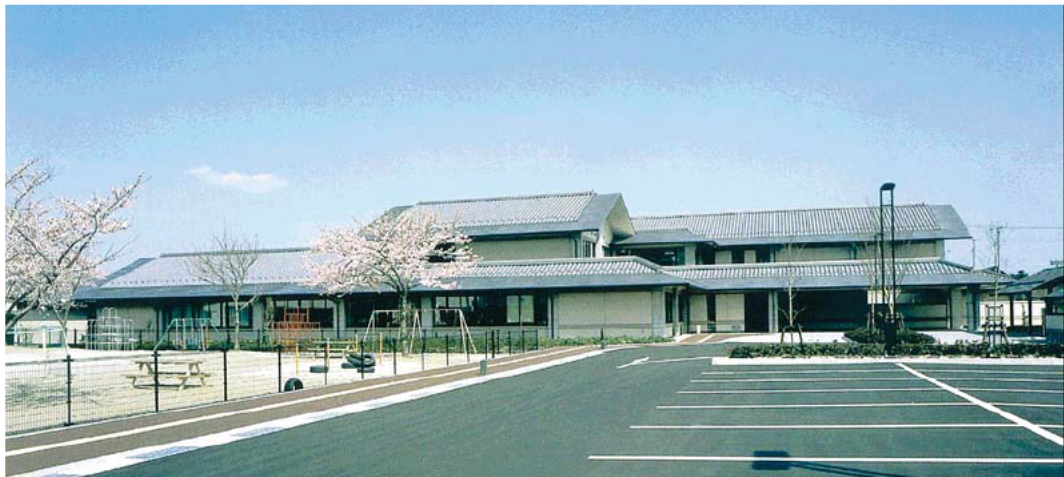
岩沼市総合福祉センター（里の杜サポートセンターが設置された施設）全景
