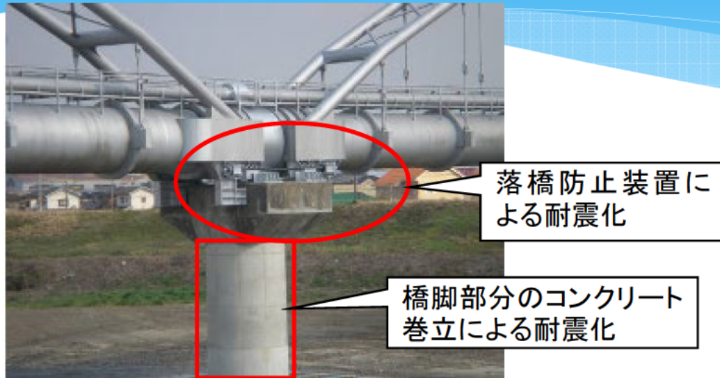
耐震化を行った三重県企業庁内部川水管橋
