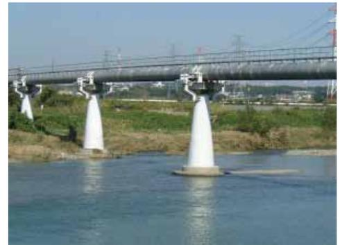
耐震補強後の員弁川水管橋
