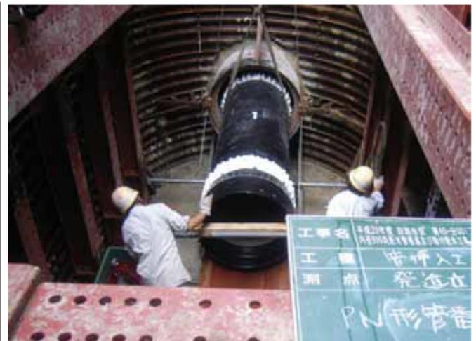
内径800mm配水管推進及び取付配管工事
