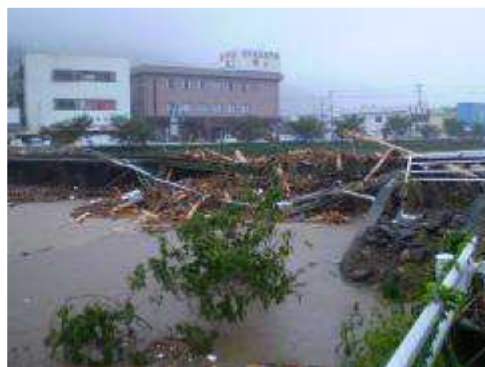
県内に甚大な被害をもたらした紀伊半島大水害(平成23年9月)
