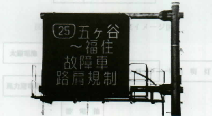
図1-2-7 太陽電池システムから電気の供給を受ける道路情報板
