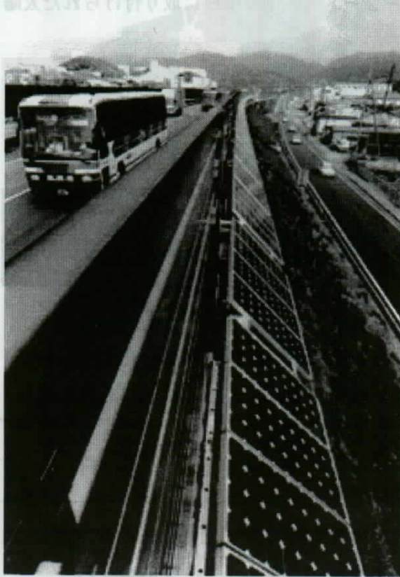
図1-2-6 国道の遮音壁にとりつけられた太陽電池 (名阪国道、天理インターチェンジ付近)
