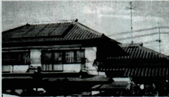
図1-2-8 住宅の屋根に取り付けられた太陽電池
