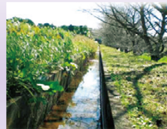
大切な用水を田に引くための新田水路
