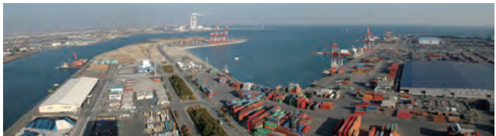
霞ヶ浦地区のコンテナターミナル(四日市港管理組合提供)
