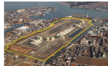
供用を開始した宮川浄化センター(伊勢市大湊)
