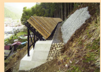
間伐材緩衝工（落石防護柵）（熊野市）
