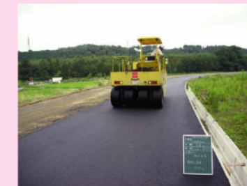
再生アスファルトを用いた道路舗装 伊賀県民局(名張市)
