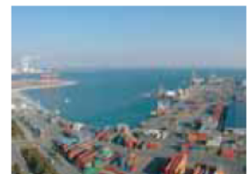
コンテナターミナル(四日市市)
