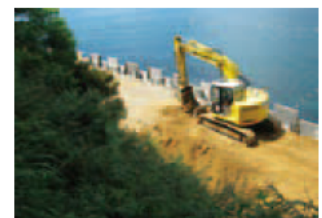
建設発生土の工事間流用 熊野建設事務所(熊野市)
