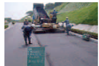
再生アスファルトを用いた道路舗装 志摩建設事務所(志摩市)
