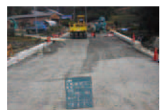
再生砕石(RC-40)を 路盤材として利用 伊賀建設事務所(伊賀市)
