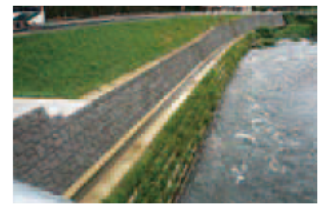
河川・護岸工事(大紀町)
