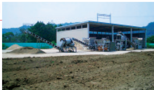
グラウンド改良材の製造 (高野浄水場) ▶
