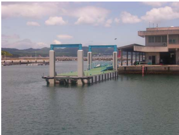
完成した浮棧橋
