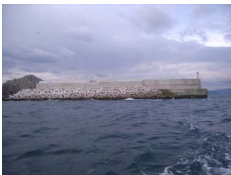
完成した南防波堤
