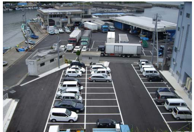
駐車場が整備され運搬車両と一般車両分離されました
