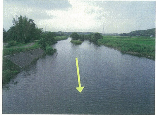
③海蔵川事業区間上流 (代官橋)
