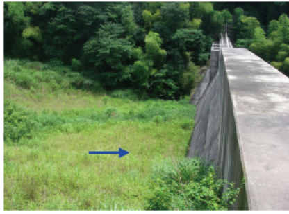
③ 堰堤(下流側)背後状況
