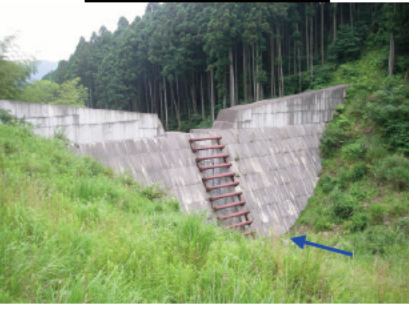
② 堰堤(上流側)背後状況
