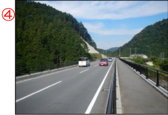
栗野橋整備後
