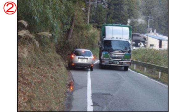
幅員狭小により対向車とのすれ違い困難
