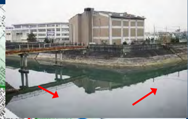
釜屋川合流点、釜屋排水機場
