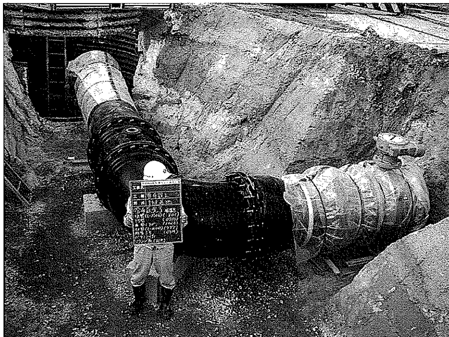
工業用水の需要増に対応した施設整備として実施した配水管の布設状況 〔内径800耗配水管シールド工事(四期・山之ー色)：平成21年度完成〕
