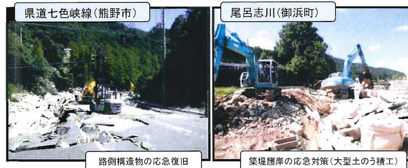
崩落土砂撤去
