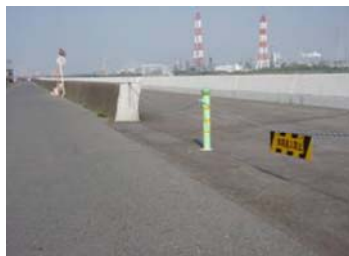
07 堤防沿いの車両進入の禁止策(右岸)
