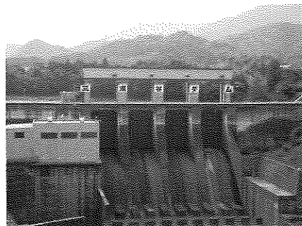
三瀬谷発電所
