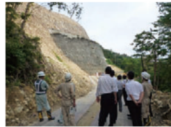
地滑り防止区域での調査(福島県)
