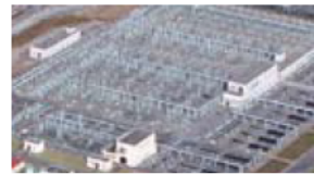
北部浄化センター
