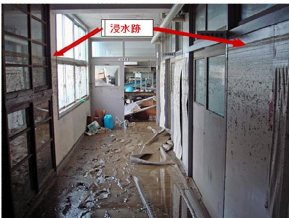
図 12 化学実験室前廊下(泥が堆積し部屋の中は備品が散乱して入室できない状態)
