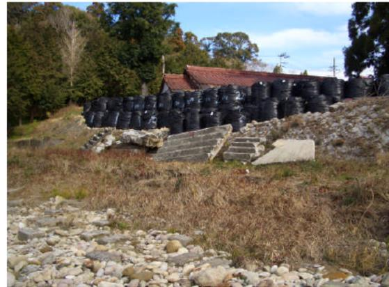
図 3 学校裏手の決壊場所は仮復旧で 20m 近く土嚢が積まれた状態 (2012 年 3 月 1 日現在)
