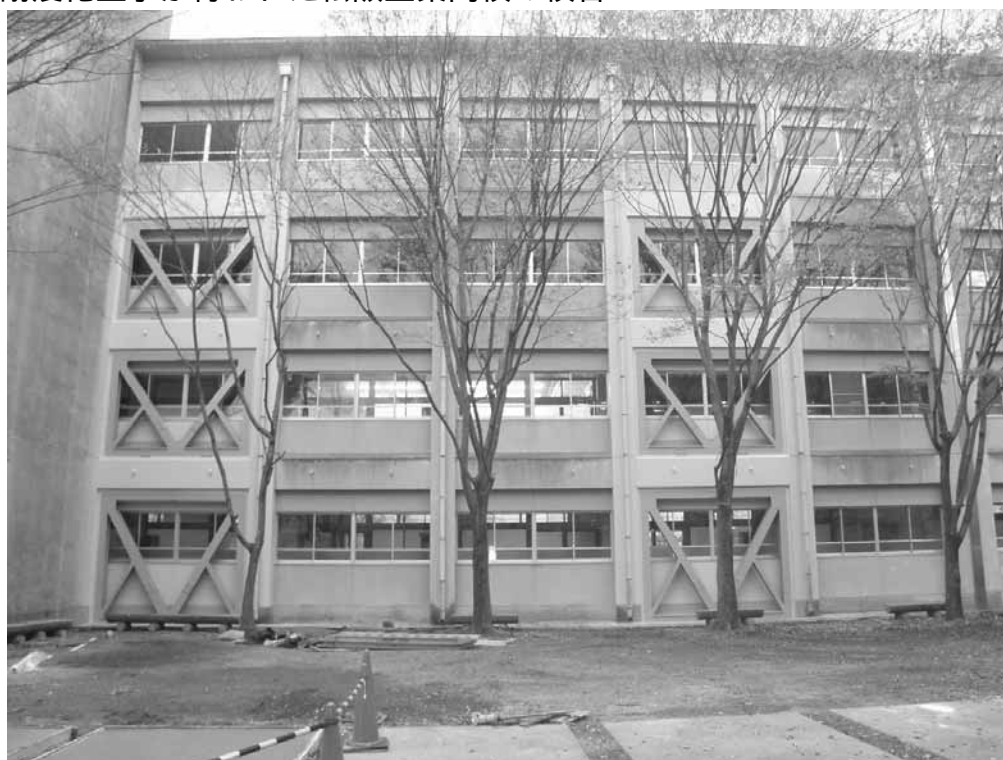
耐震化工事が行われた松阪工業高校の校舎
