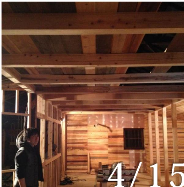
▶天井工事完了。端材を活用しているため、幅と樹種の異なる材をランダムに貼り込み。
