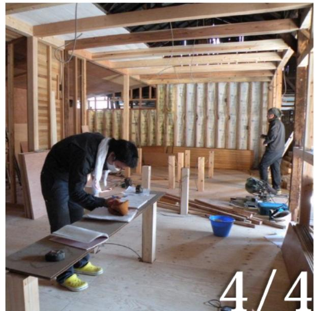
▶内装工事。基礎となる壁柱・間柱の設置を行い、その上に壁材（端材で構成）を貼り込み。
