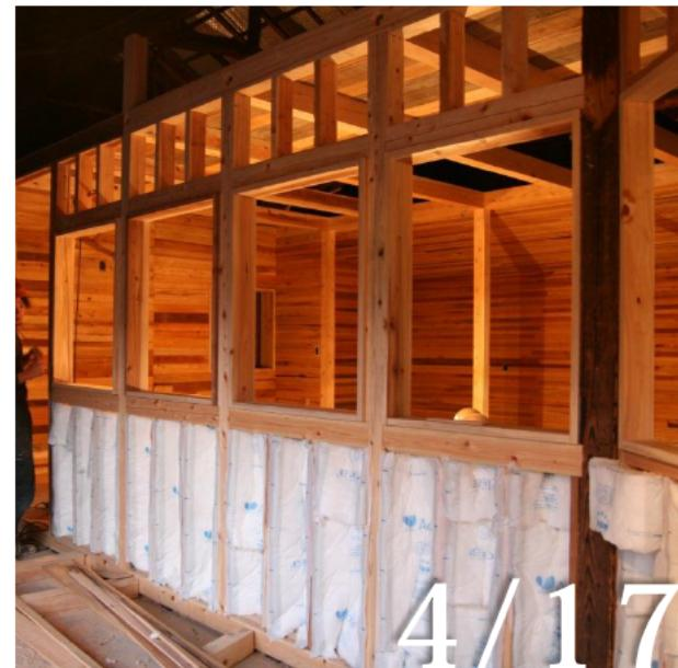
▶断熱材貼り込み。周囲を360° 断熱材で囲むことで熱効率の最大化を目指す。
