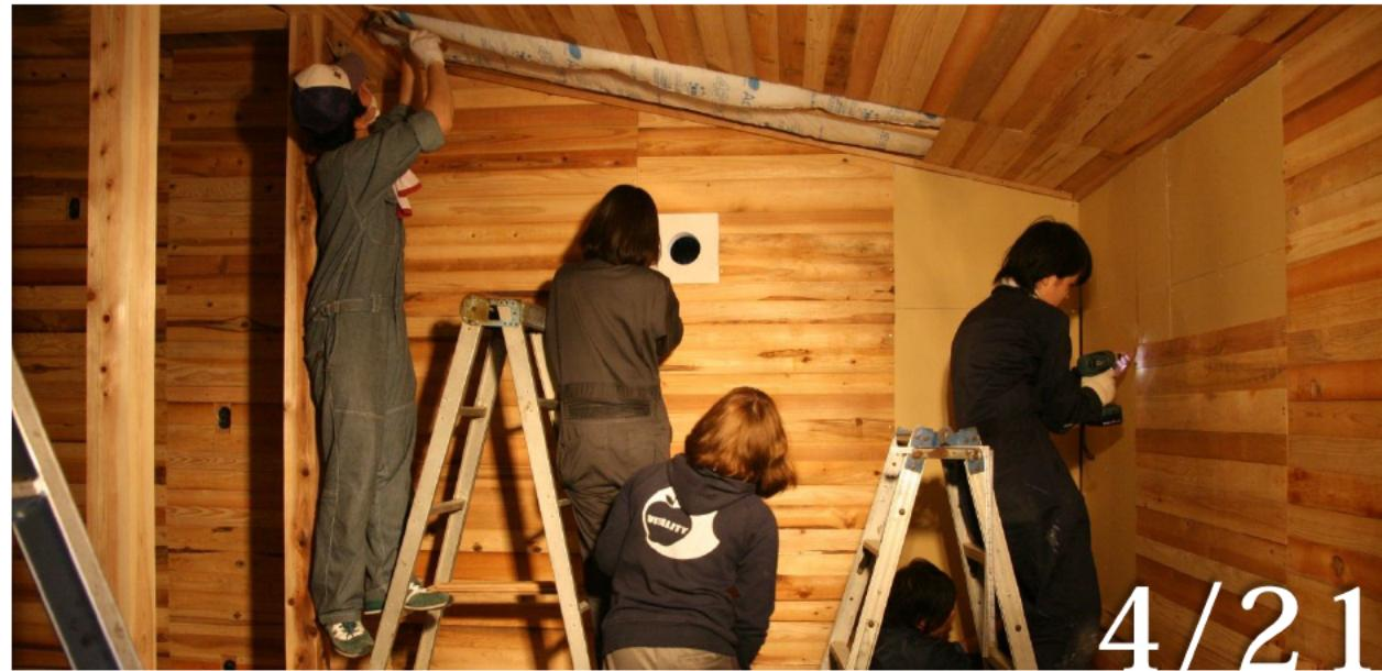
▶土間の内装材貼り込み。土間には薪ストーブを設置するため、下地に不燃材（石膏ボード）を貼り込み、仕上げ材として幅の異なる木板（端材）を貼り込み。学生が多い日を狙い一気に作業を進行。
