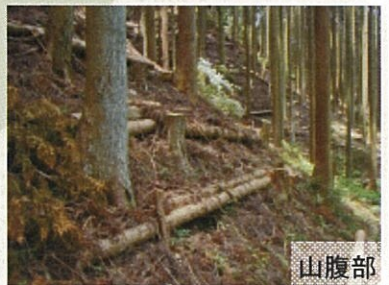
伐倒木を利用した土砂止の設置
