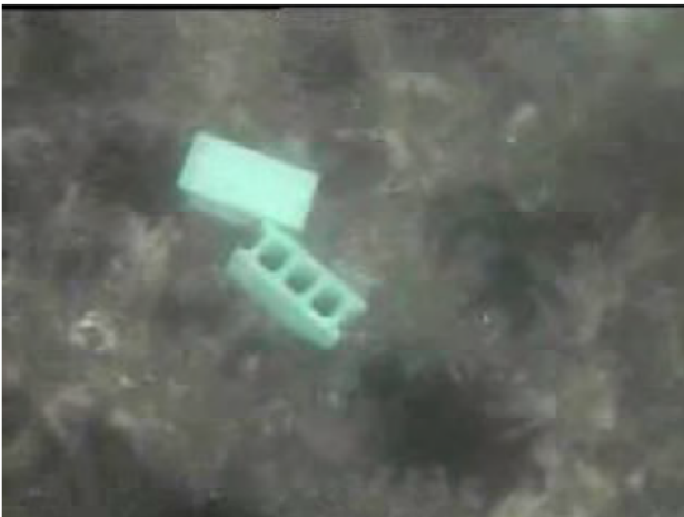
写真4 ブロック設置状況
