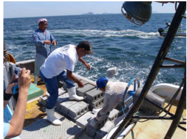
写真3 ブロック投入作業2
