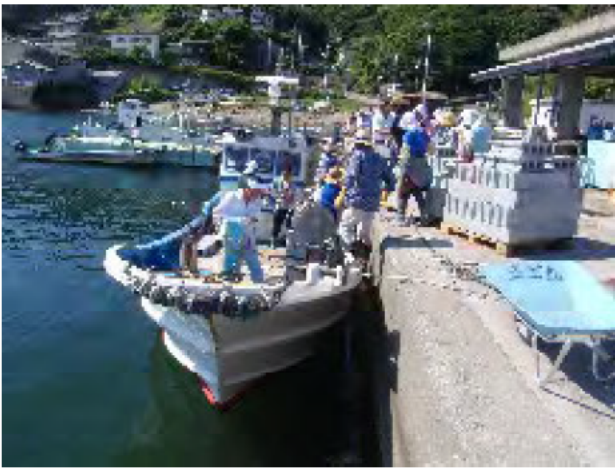
写真2 ブロック投入作業1
