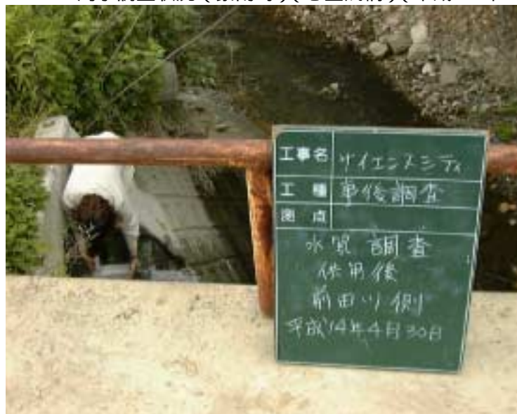
写真 4 - 6 - 33 供用後排水調査状況（サイ以前田川側）（平成 14 年 4 月 30 日）
