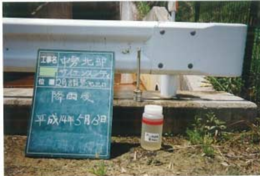
写真4 - 6 - 2 濁水調査状況（通常降雨時）（2号調整池出口）（平成14年5月13日）
