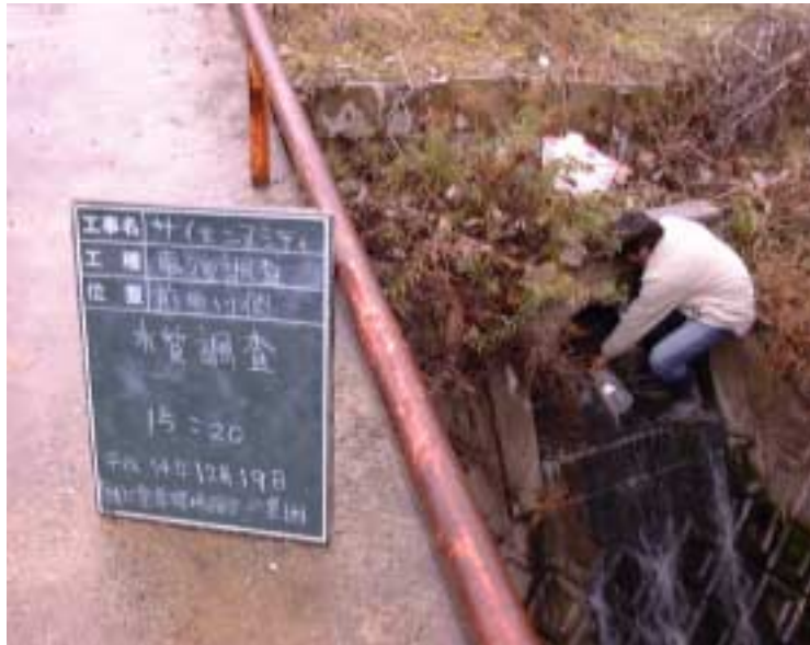
写真4 - 6 - 41 供用後排水調査状況（サイエ以前田川側）(平成14年12月19日)
