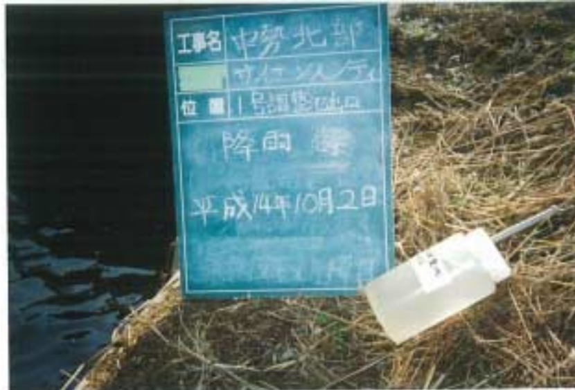
写真4 - 6 - 17 濁水調査状況（豪雨時）（1号調整池出口）（平成14年10月2日）
