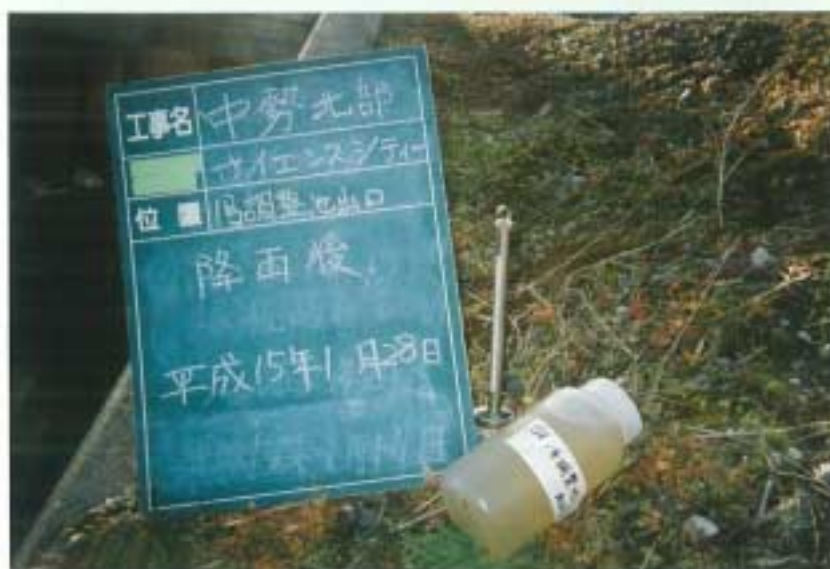
写真4 - 6 - 29 濁水調査状況（豪雨時）（1号調整池出口）（平成15年1月28日）
