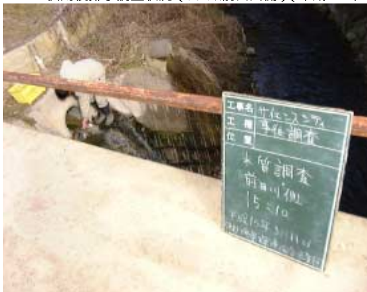
写真4 - 6 - 44 供用後排水調査状況（サレ以前田川側）（平成15年3月11日）
