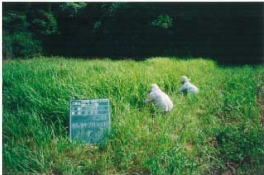
写真 4 - 8 - 14 整備状況 (除草工 (人力): 除草作業中・ハシヨウ ® 植栽地 : 平成 14 年 7 月 30 日)
