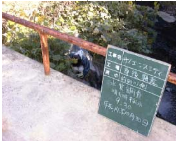
写真4 - 6 - 39 供用後排水調査状況（サイエンス前田川側）（平成14年10月30日）
