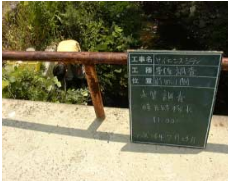
写真 4 - 6 - 36 供用後排水調査状況（サエ以前田川側）（平成 14 年 7 月 24 日）
