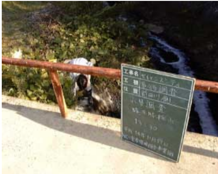
写真4 - 6 - 40 供用後排水調査状況（サイエ以前田川側）(平成14年11月19日)
