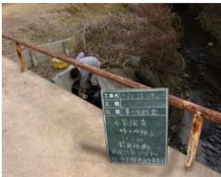
写真4 - 6 - 43 供用後排水調査状況（サレ以前田川側）（平成15年2月19日）
