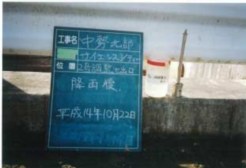
写真4 - 6 - 22 濁水調査状況（通常降雨時）（2号調整池出口）（平成14年10月22日）
