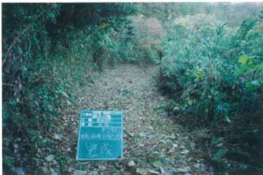
写真 4 - 8 - 21 整備状況 (除草工：除草後・保全区域A・通路：平成 14 年 11 月 22 日)
