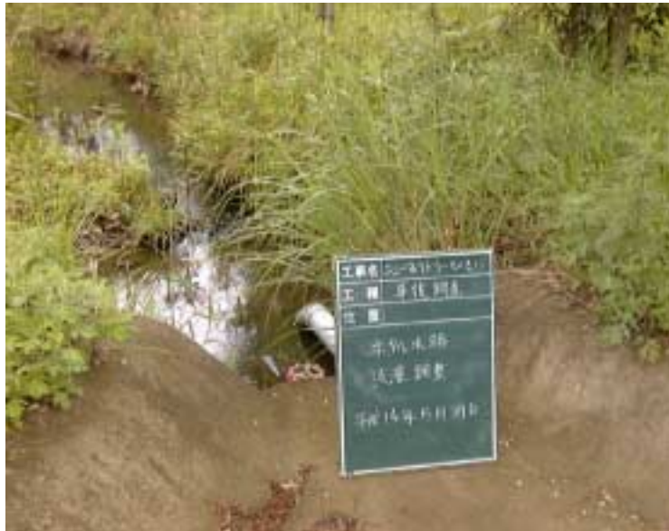
写真 6 - 4 - 17 水たれ水路流量調整（平成 14 年 5 月 31 日）
