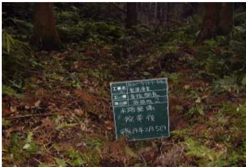
写真6 - 3 - 7 移殖地整備状況（整備後）移殖地第2区域 平成14年2月5日
