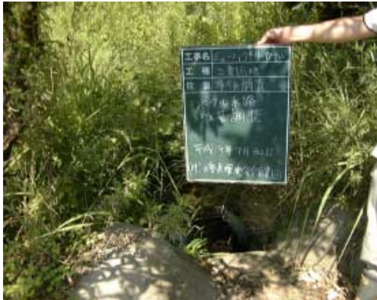
写真 6 - 4 - 23 水たれ水路流量調整（平成 14 年 7 月 30 日）
