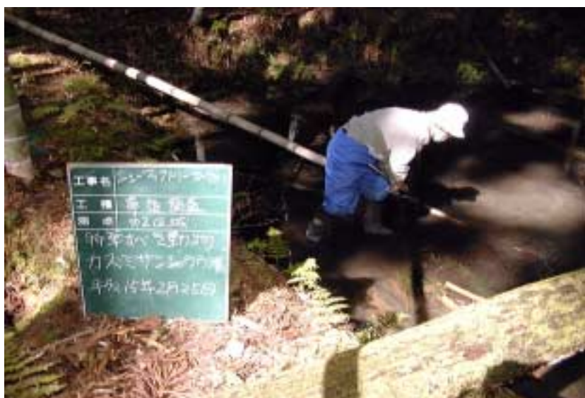
写真6 - 3 - 102 加サツヨウ材調査状況（移殖地第2区域）平成15年2月25日
