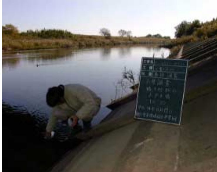
写真3 - 32 供用後採水状況 (小戸木橋)(平成14年11月19日)
