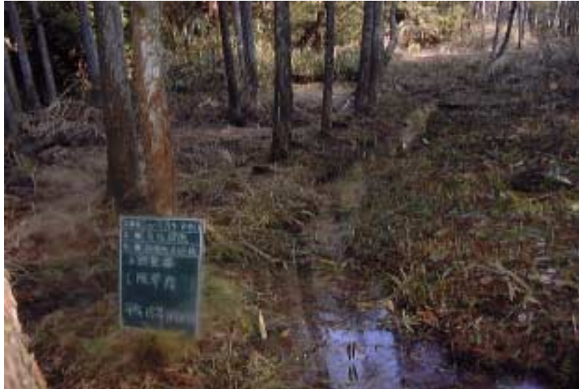
写真 6 - 3 - 94 移殖地整備状況（整備後）移殖地第 1 区域 平成 15 年 1 月 10 日
