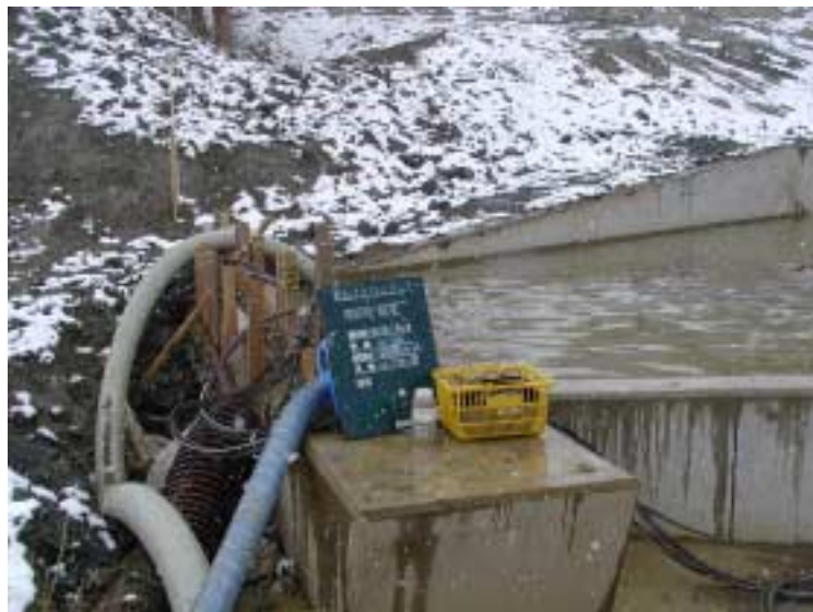
写真 2 - 2 - 1 濁水調査状況 (調整池 A) (平成 15 年 3 月 4 日)
