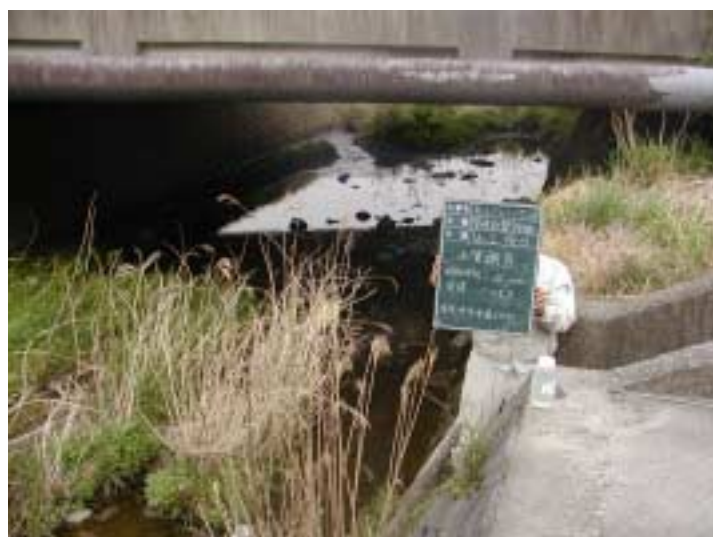
写真 2 - 1 - 2 水質調査状況 ( 2 桜川 )(平成 14 年 4 月 15 日)
