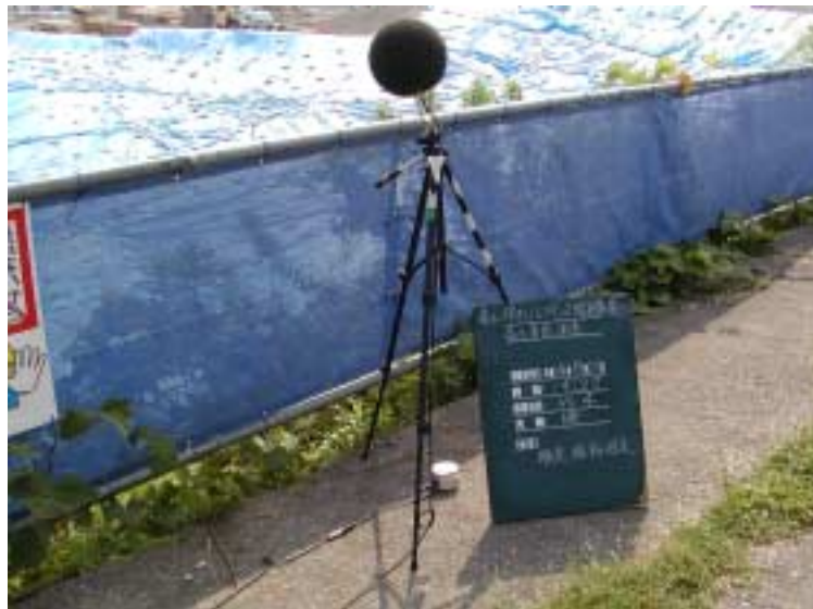
写真3 - 4 騒音・振動調査状況（敷地境界 4）(平成14年8月26日)
