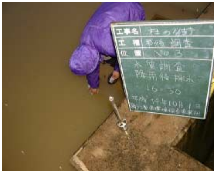
写真3 - 31 濁水採水状況 ( 3 ) H14年10月1日
