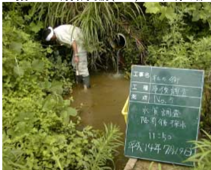
写真3 - 26 濁水採水状況 ( 5 ) H14年7月19日
