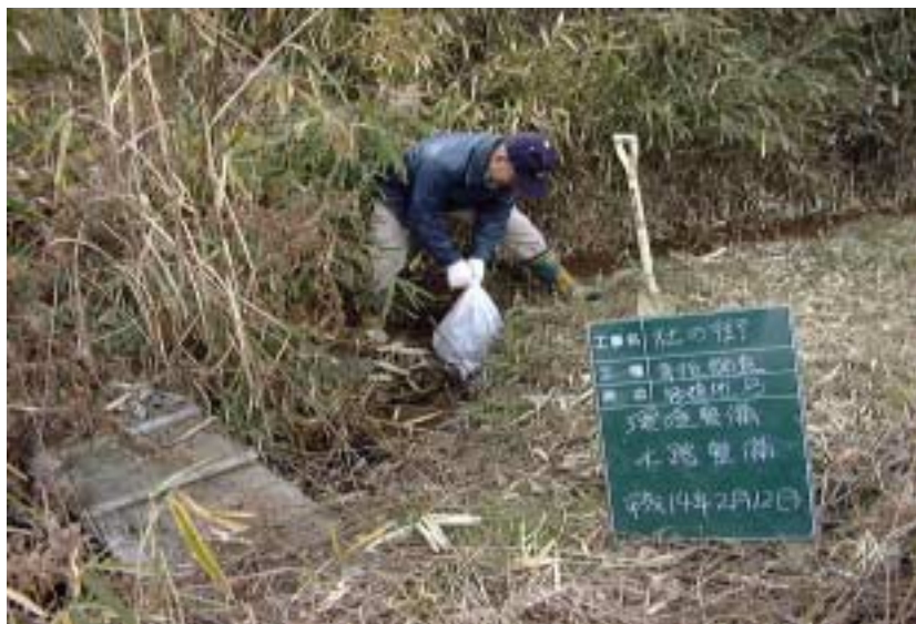
写真6 - 14 移殖地整備状況（水路整備状況）移殖地 B 平成14年2月12日
