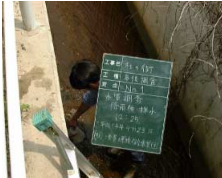
写真3 - 1 濁水採水状況 ( 1 ) H14年4月23日
