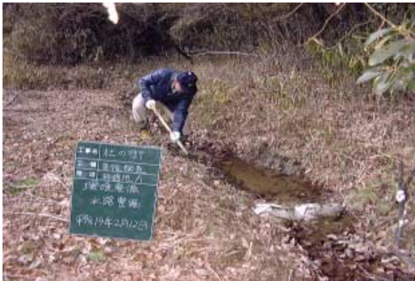
写真 6 - 11 移殖地整備状況（水路整備状況）移殖地 A 平成 14 年 2 月 12 日
