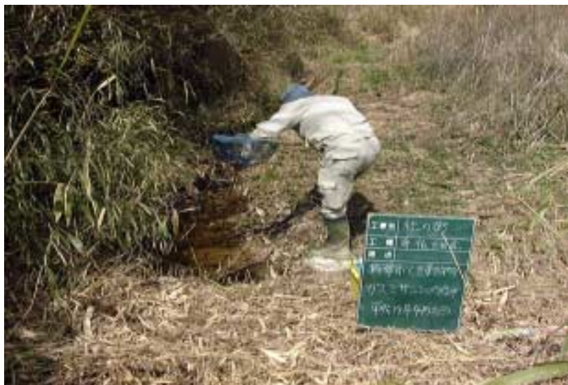
写真 6 - 23 加ミサツヨウ材調査状況 平成 14 年 4 月 2 日
