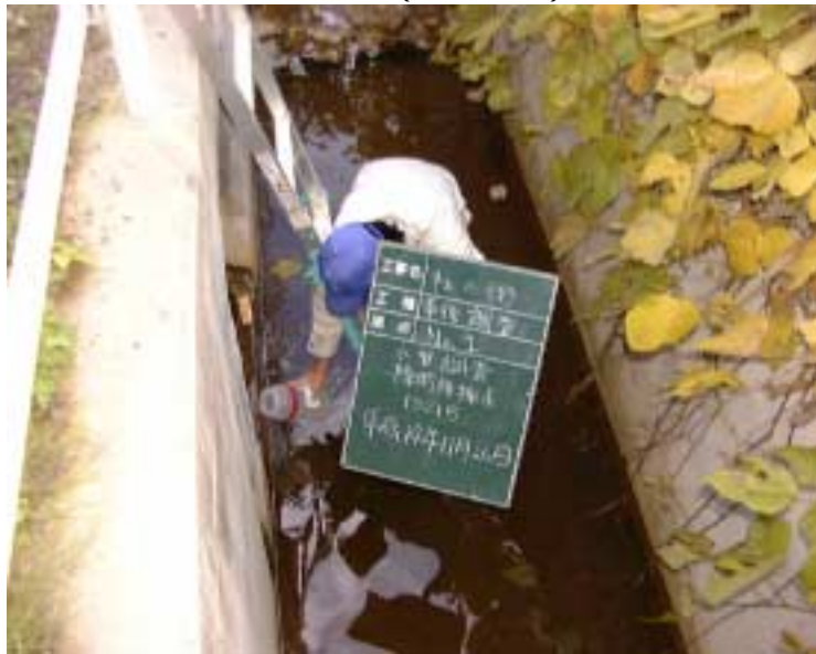
写真 3 - 36 濁水採水状況 ( 1 ) H14 年 11 月 26 日
