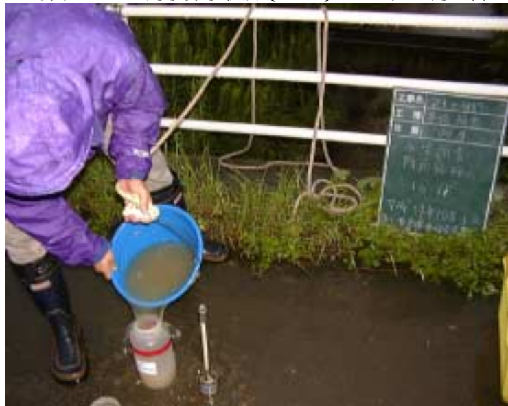
写真3 - 32 濁水採水状況 ( 4 ) H14年10月1日
