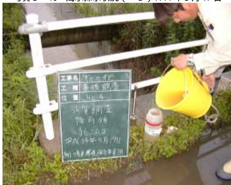
写真3 - 11 濁水採水状況 ( 4 ) H14年5月17日
