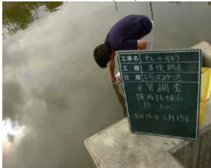
写真3 - 17 濁水採水状況 ( 3 ) H14年6月13日
