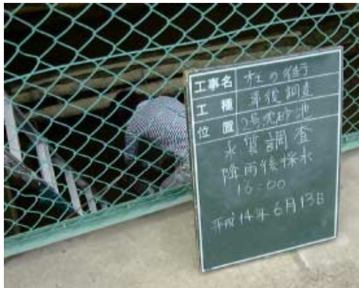
写真3 - 16 濁水採水状況 ( 2 ) H14年6月13日
