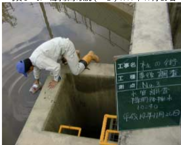
写真3 - 38 濁水採水状況 ( 3 ) H14年11月26日
