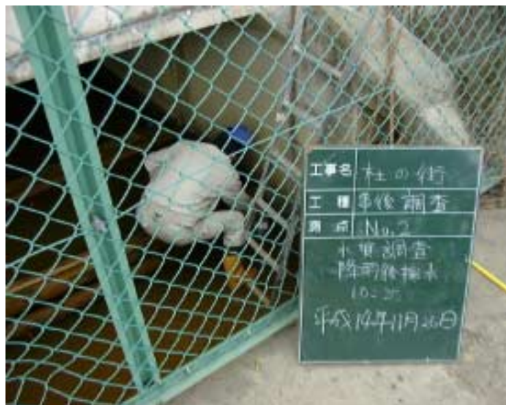
写真3 - 37 濁水採水状況 ( 2 ) H14年11月26日
