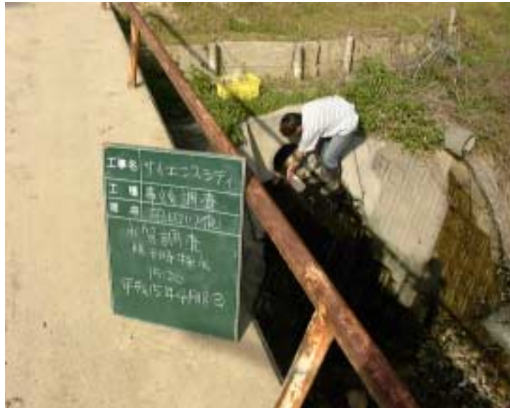
写真 4 - 6 - 34 供用後排水調査状況（サエ以前田川側）（平成 15 年 4 月 18 日）
