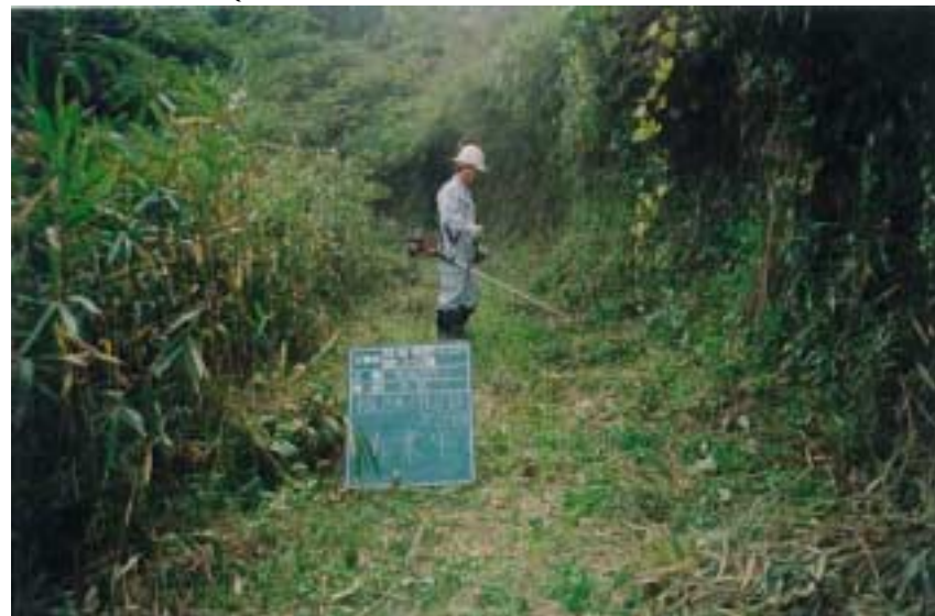
写真 4 - 8 - 23 整備状況 (除草工 : 除草作業中・保全区域 A・通路 : 平成 15 年 10 月 31 日)
