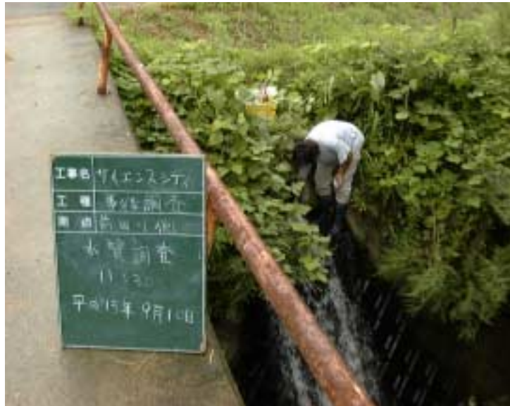
写真 4 - 6 - 44 供用後排水調査状況 (サイ以前前田川側) (平成 15 年 9 月 10 日)
