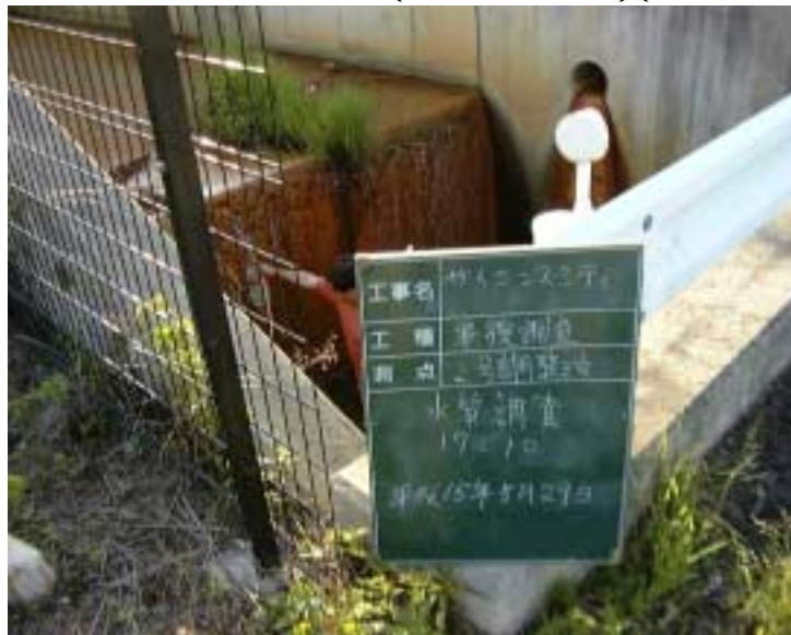
写真 4 - 6 - 57 農業用水調査状況 (2号調整池出口)(平成 15 年 5 月 29 日)
