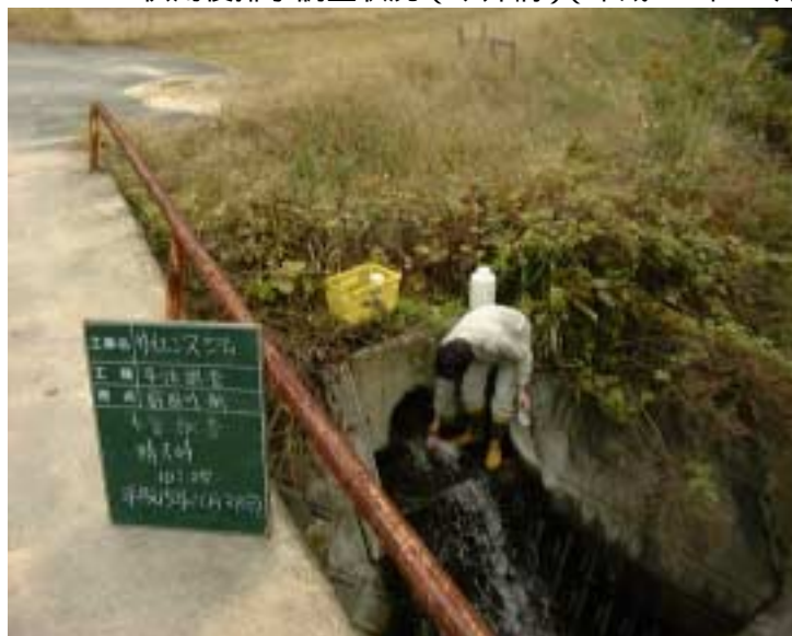
写真 4 - 6 - 48 供用後排水調査状況（サイン以前田川側）（平成 15 年 11 月 28 日）
