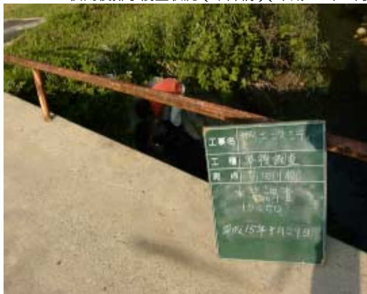
写真 4 - 6 - 36 供用後排水調査状況（サエ以前田川側）（平成 15 年 5 月 29 日）
