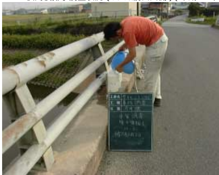
写真 4 - 6 - 45 供用後排水調査状況 (今井橋) (平成 15 年 10 月 8 日)
