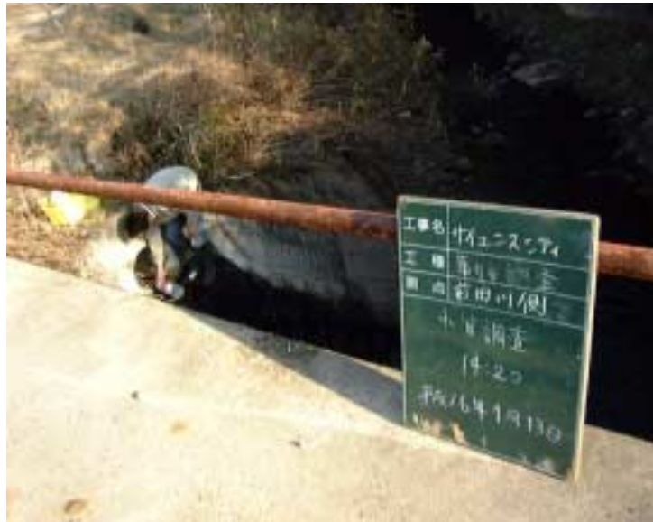
写真4 - 6 - 52 供用後排水調査状況（サイエンスシティ以前前田川側）（平成16年1月13日）
