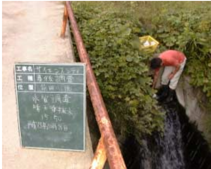
写真 4 - 6 - 46 供用後排水調査状況（サイン以前田川側）（平成 15 年 10 月 8 日）
