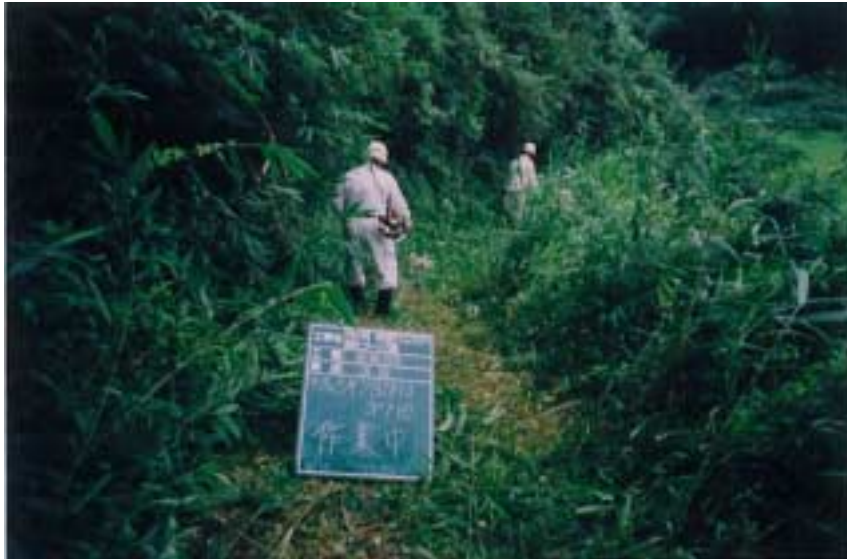
写真 4 - 8 - 5 整備状況（除草工：除草作業中・保全区域 A・通路：平成 15 年 7 月 28 日）
