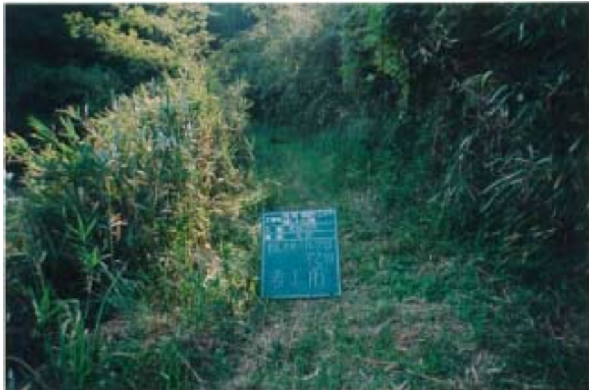
写真 4 - 8 - 22 整備状況 (除草工 : 除草前・保全区域 A・通路 : 平成 15 年 10 月 29 日)
