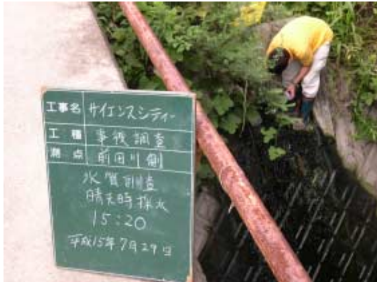
写真4 - 6 - 40 供用後排水調査状況（サインズ前田川側）（平成15年7月29日）
