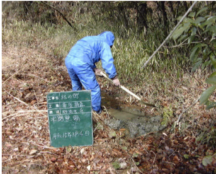
写真6 - 11 移殖地整備状況（水路整備状況）移殖地 A 平成15年3月4日
