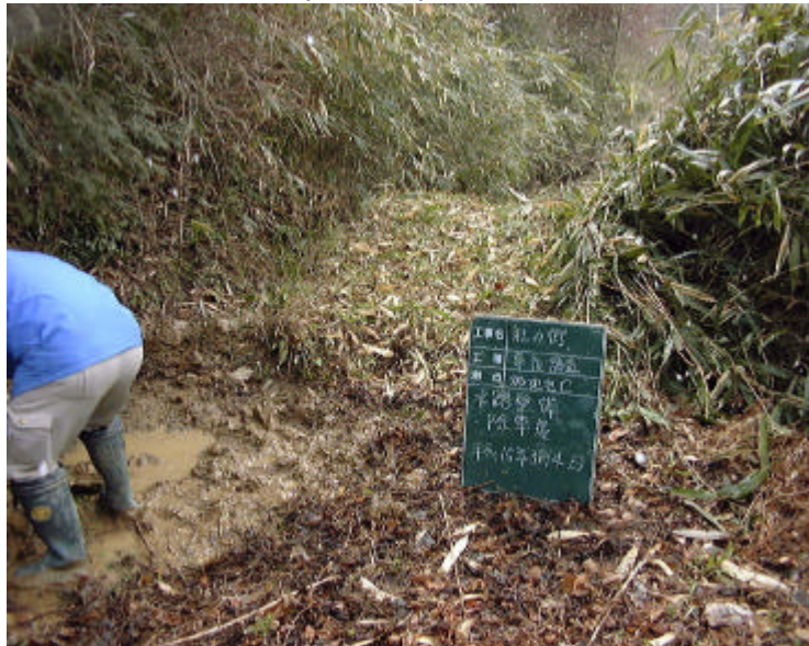
写真6 - 16 移殖地整備状況（整備後）移殖地 C 平成15年3月4日
