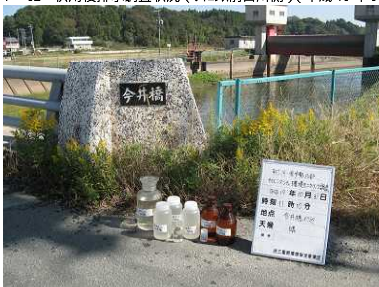
写真4 - 1 - 33 供用後排水調査状況 (今井橋)(平成19年10月31日)
