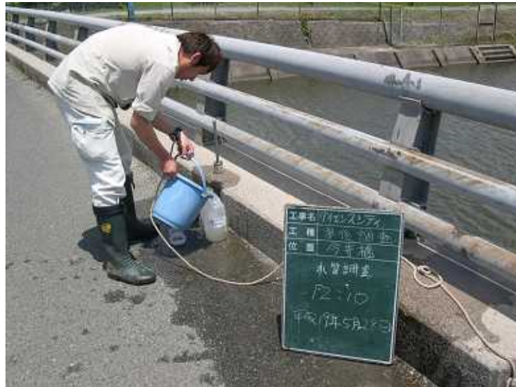
写真4 - 1 - 23 供用後排水調査状況（今井橋）（平成19年5月28日）
