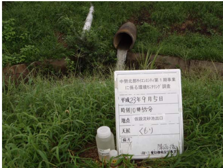
写真4-1-31 濁水調査状況（豪雨時）（3号調整池出口）（平成23年9月5日）
