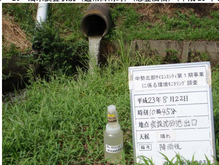
写真4-1-27 濁水調査状況（通常降雨時）（3号調整池出口）（平成23年8月22日）
