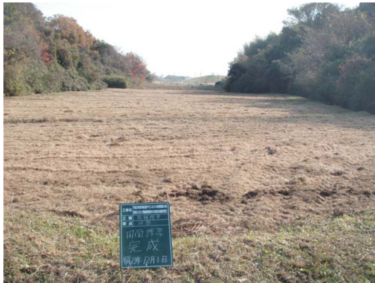
写真4-3-20 整備状況（除草工：除草後・保全区域A・放棄水田：平成23年12月1日）
