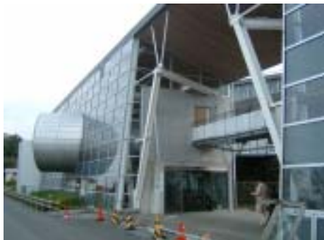
笛田リサイクルセンターの外観
