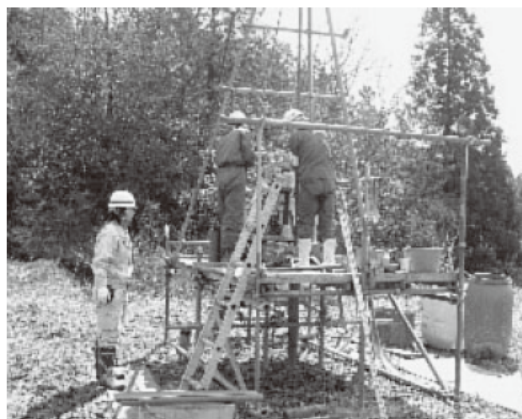
地質調査（ボーリング調査）
