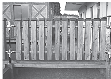
フェンス正面写真
