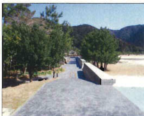
三木里地区（尾鷲市） 三木里海岸堤防
