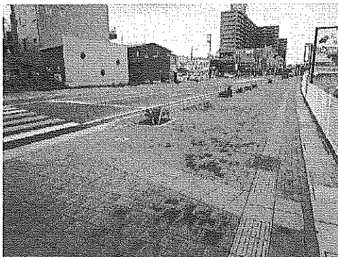
幅の広い歩道（県道久居停車場津線）
