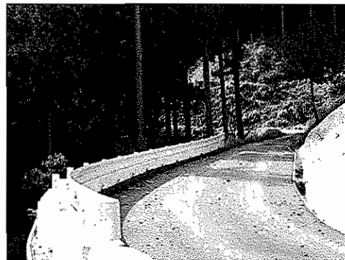
【①取付道路復旧（H25.3完成）】
