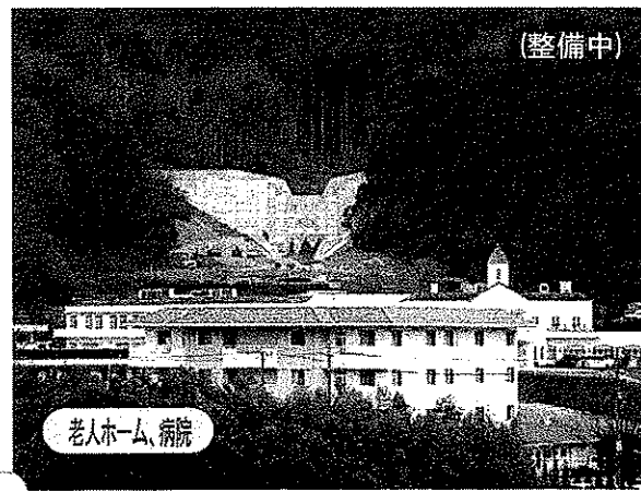
砂防堰堤の整備
