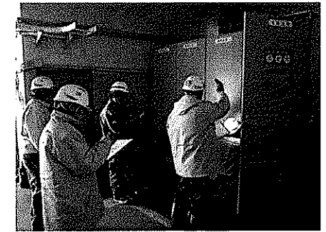
電気設備点検業務
