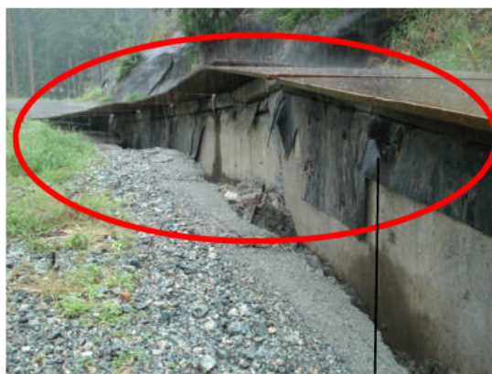
導水路側壁露出
