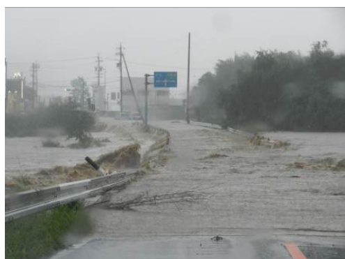
台風第11号による越流現場（津市殿村三泗地内）（写真提供：津市）
