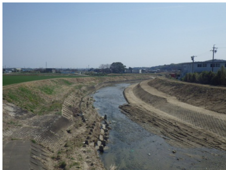
穴倉川堆積土砂の撤去（津市）
