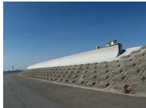
海岸堤防の嵩上げ（桑名市）
