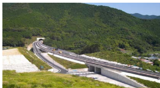
ミッシングリンクの解消（熊野尾鷲道路 新鹿中山地区）
