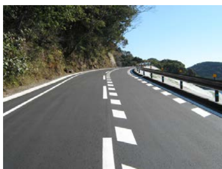
国道311号拡幅（熊野市甫母）
