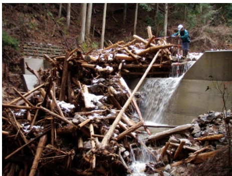
治山施設に異常堆積した流木の除去（亀山市）
