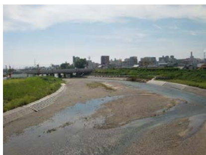
三滝川広域河川改修（四日市市）
