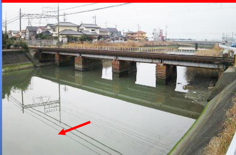
堀切川(近鉄橋梁)
