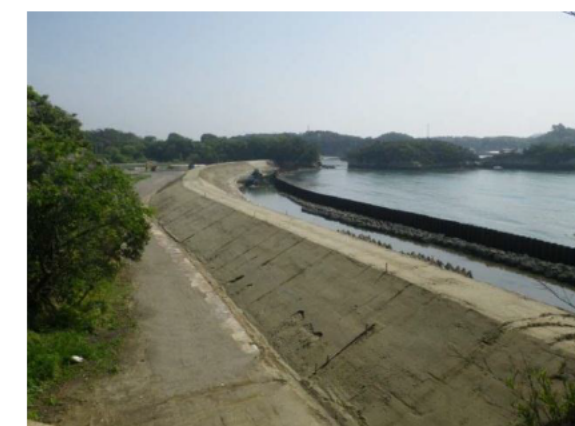
堤防盛土 平成27年3月
