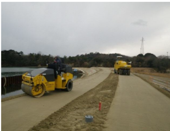
堤防盛土 平成26年10月～平成27年3月
