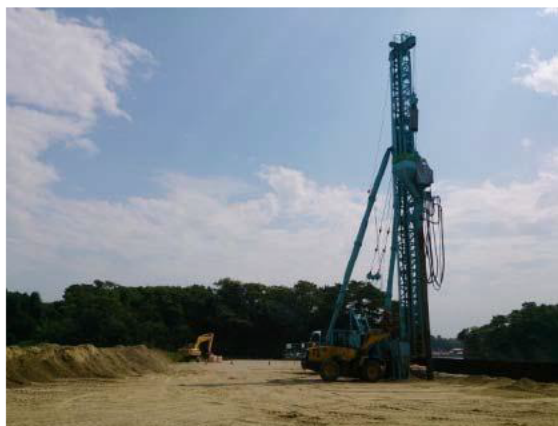
地盤改良 平成26年8～9月
