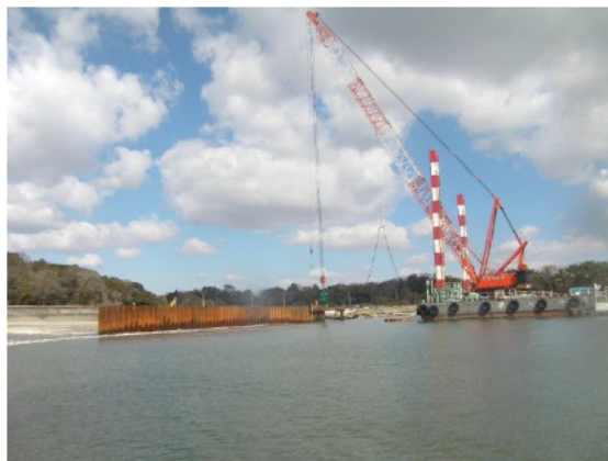
仮締切矢板打設 平成26年4～5月
