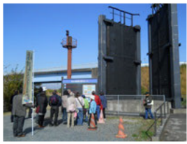
<船頭平閘門明治の水門扉>
